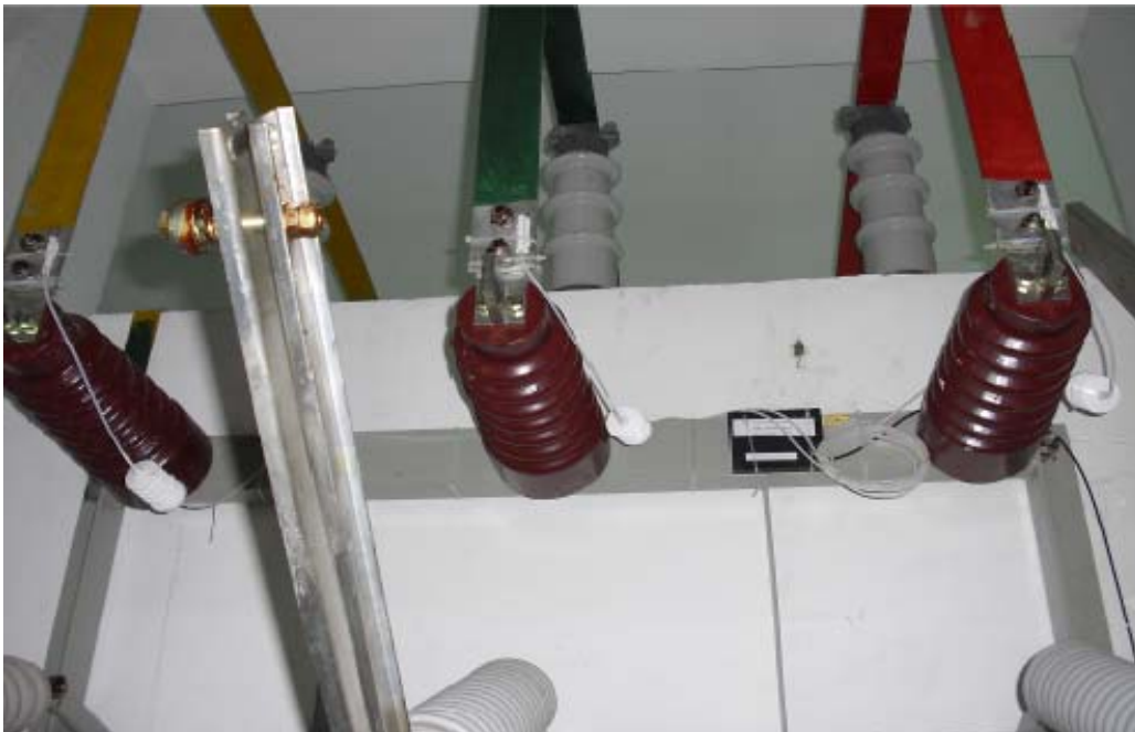
35KV 及以上高耐压等级光纤光栅温度传感器
